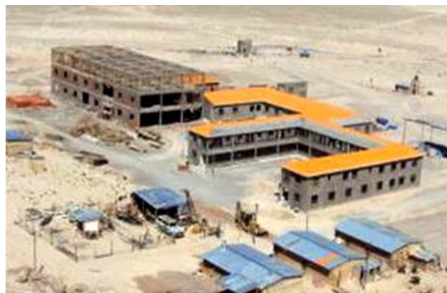
Planta Piloto en construcción
