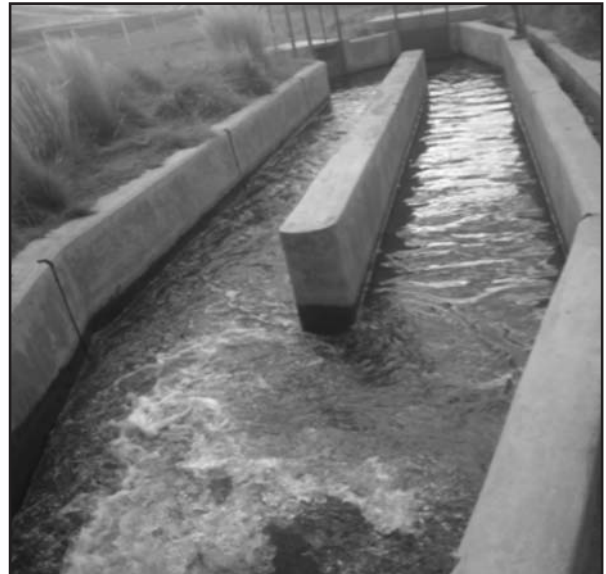
FIGURA N° 15 Cámara de distribución
